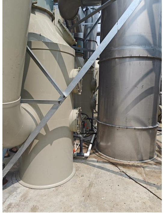
车间内收集废气通过的喷淋塔
