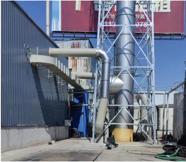
车间内收集废气通过的喷淋塔
